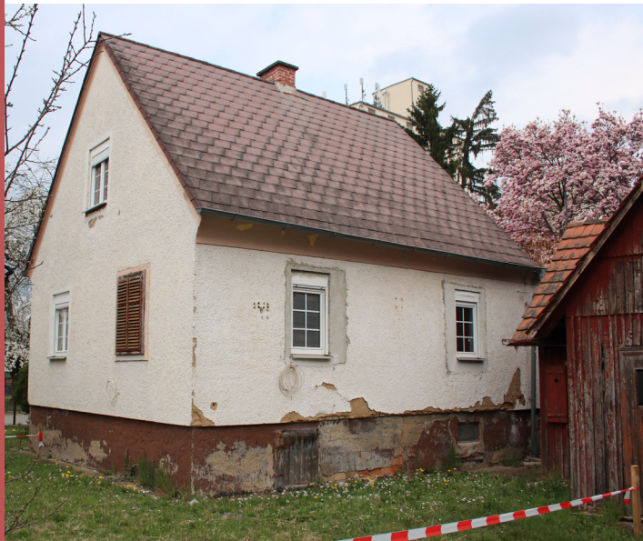
Beim Rückbau dieses Hauses fallen weniger als 750 t Bau- und Abbruchabfälle an.
