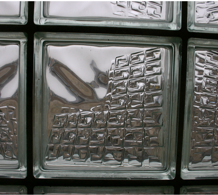
Glasbausteine sind ein Störstoff beim Recycling von Baurestmassen
