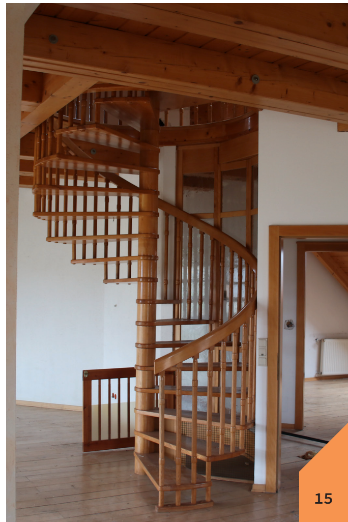
Diese Wendeltreppe wurde wieder verwendet, nachdem sie einer Prüfung und Reparatur unterzogen wurde.
