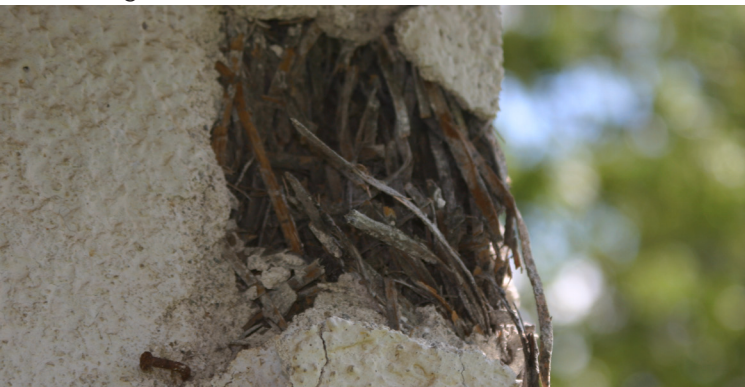
Zementgebundene Holzfasern sind ein Störstoff
