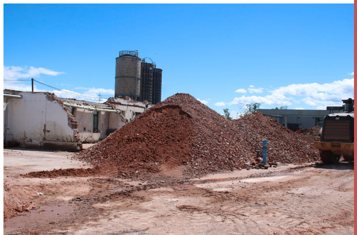
Zwischenlagerung von Abbruchmaterial auf einer Baustelle
