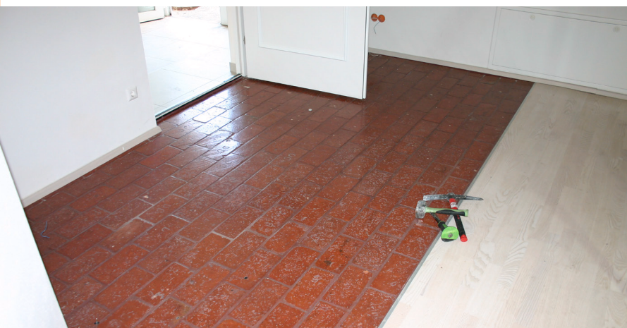
Ein neuer Boden aus alten Ziegelbodenplatten
