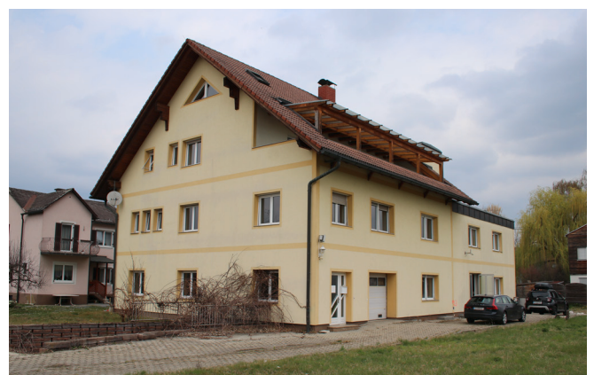
Beim Rückbau dieses Hauses fallen mehr als 750 t Bau- und Abbruchabfälle an.
