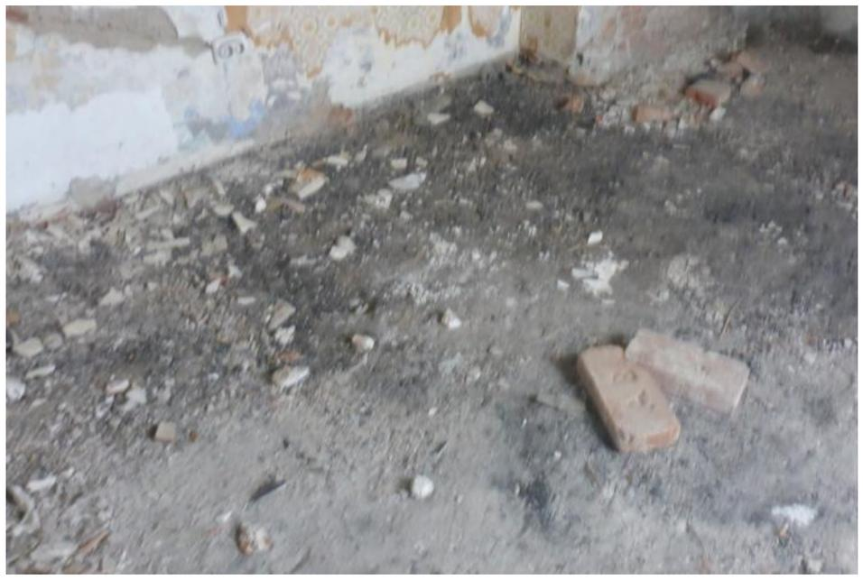
Fußbodenaufbau - Beschüttung
