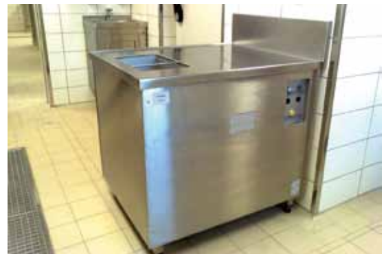
Stationäres Tanksystem – Aufgabestation im Küchenbereich (Foto: Meiko GmbH)
