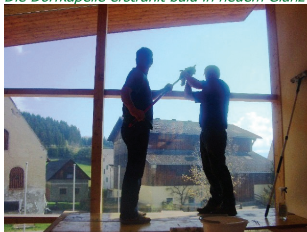
Für die Fenster des Gemeindehauses muss man schwindelfrei sein
