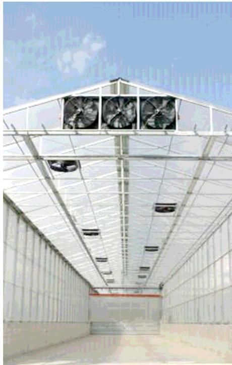
**Abbildung 32:** Trocknungshalle für solare Klärschlamm-trocknung
