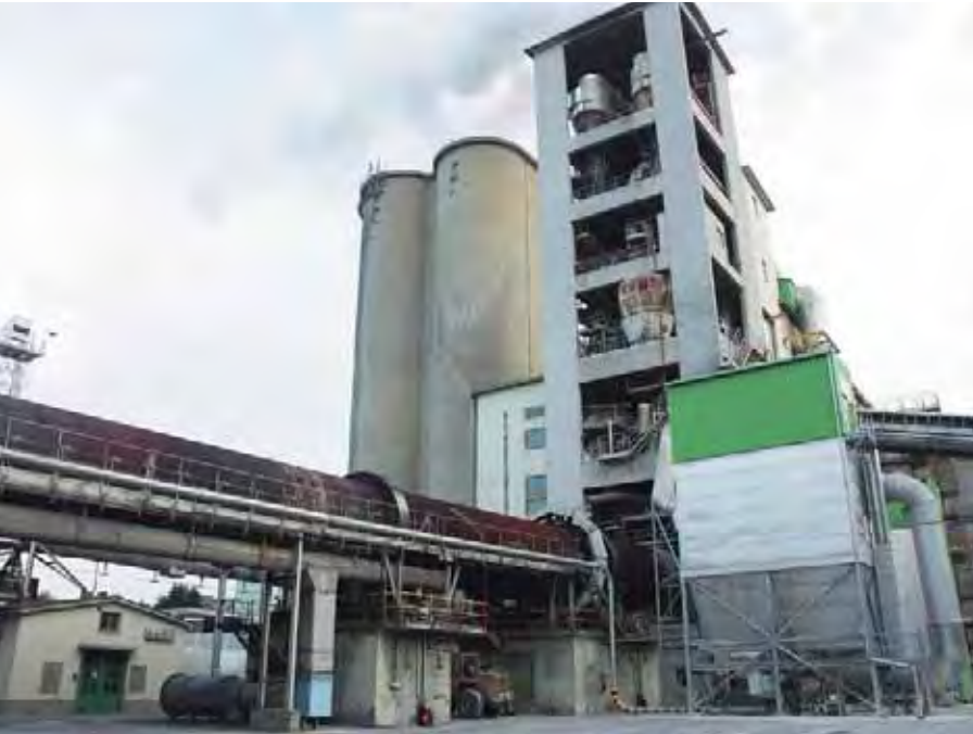
Mitverbrennung von Ersatzbrennstoffen aus Abfällen im Drehrohrföfen Zementwerk Perlmooser-Lafarge AG in Retznei.
