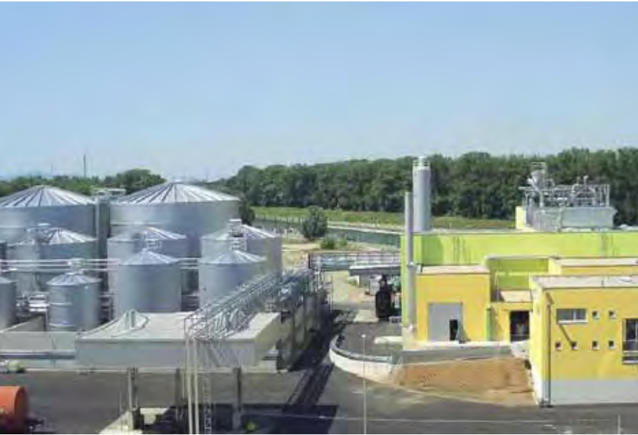
BioDiesel Vienna – mit 95.000 Tonnen pro Jahr die größte BioDiesel-anlage Österreichs, errichtet durch BDI – BioDiesel International.
