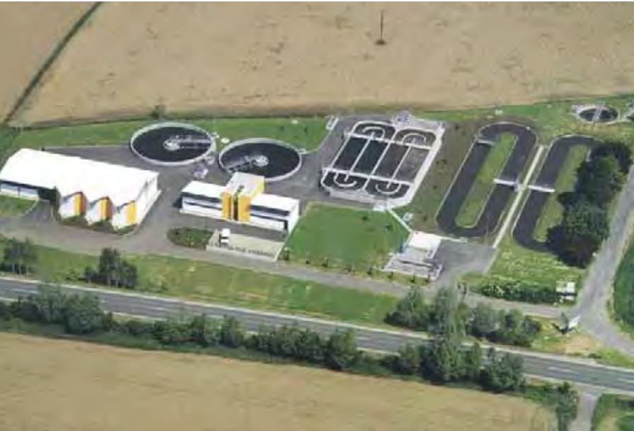
Abwasserreinigung in der Kläranlage Fehring (Foto: FA 19A).
