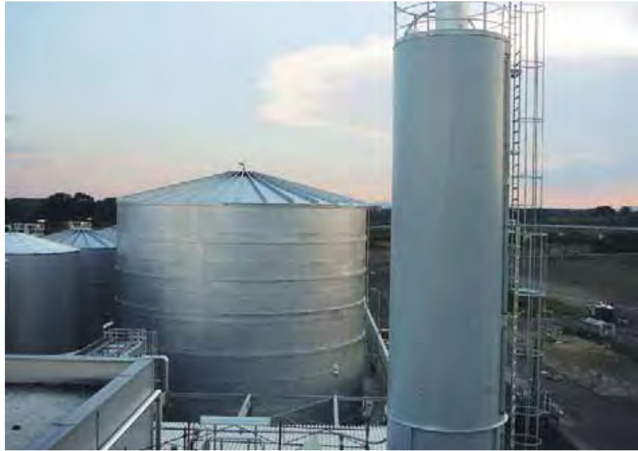
Die Biodiesel-Anlage in Wien-Lobau.
