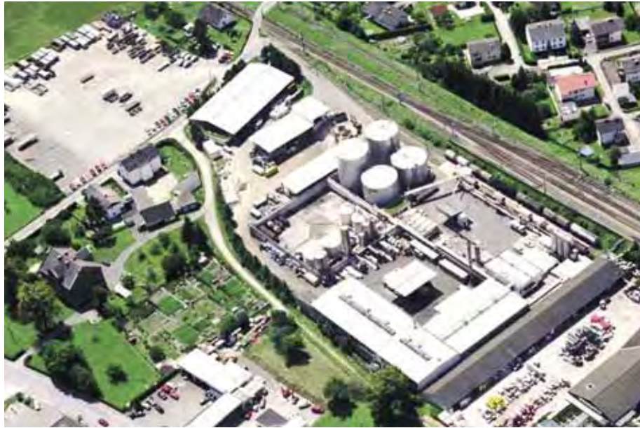
Aufbereitungsanlage Trofaiach: In der Hightech-Anlage in Trofaiach werden flüssige Abfälle (inkl. Sonderabfall) in einem modernen Umwelt-Laboratorium analysiert und anschließend fachgerecht behandelt.
