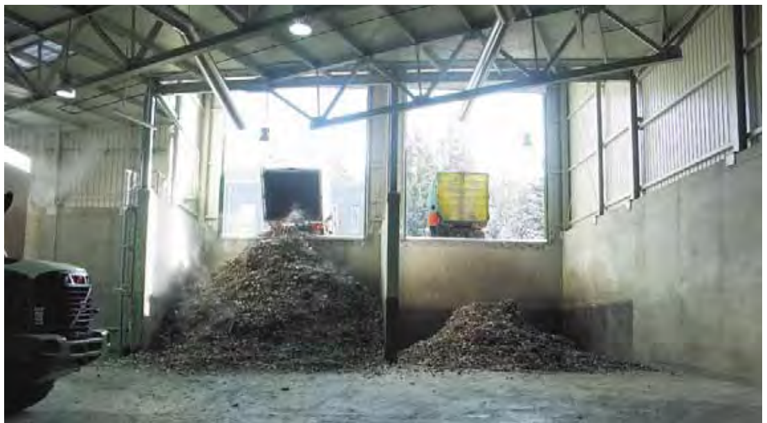
Eingehauste Abfallübernahme an der Abfallbehandlungsanlage der Servus Abfall GmbH in Frohnleiten.
