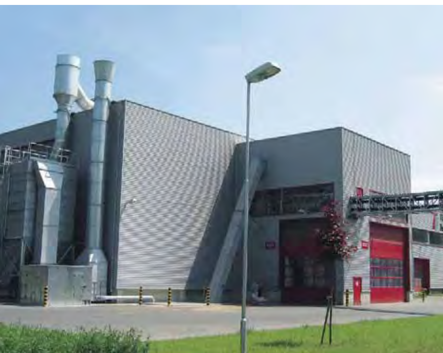
In der ThermoTeam-Anlage von Saubermacher und Lafarge in Retznei werden umweltfreundliche Ersatzbrennstoffe aus Abfällen zum Ersatz von Steinkohle erzeugt.
