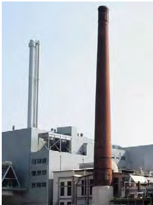
Müllverbrennungsanlage der ENAGES in Niklasdorf.
