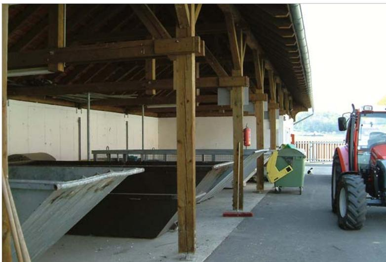
Abb. 97: ASZ Hof bei Straden – zu niedrig konstruierte Dachtraufe.
