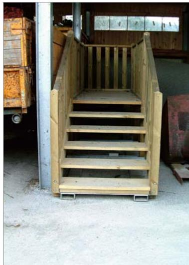
Abb. 49: ASZ Eisbach – mit Hubstapler manipulierbare Holztreppe.
