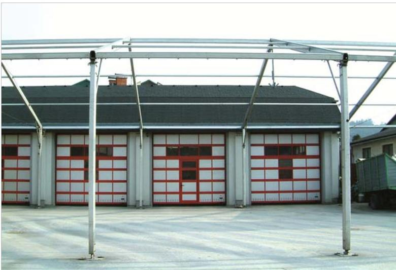
*Abb. 105: PSS Stallhofen - permanent aufgestelltes Zeltgerüst. Bei selteneren Öffnungszeiten günstige Alternative zu fixen Flugdächern.*
