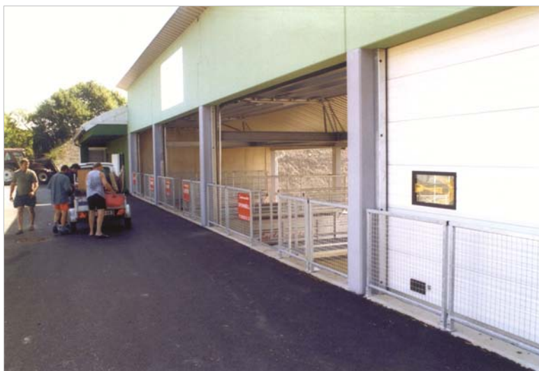
Abb. 115: ASZ Pölfing-Brunn – oberer Anliefererbereich.
