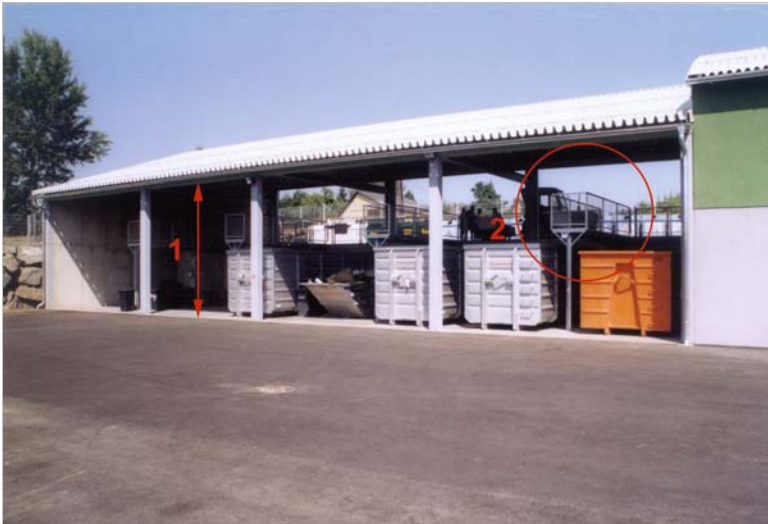
Abb. 117: ASZ Pöfing-Brunn – ausreichend hohe Dachtraufe (1) und Zugangsstege (2).
