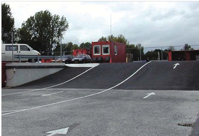
Abb. 119: ASZ-Groningen – Auffahrtsrampe in die „obere Ebene“.
