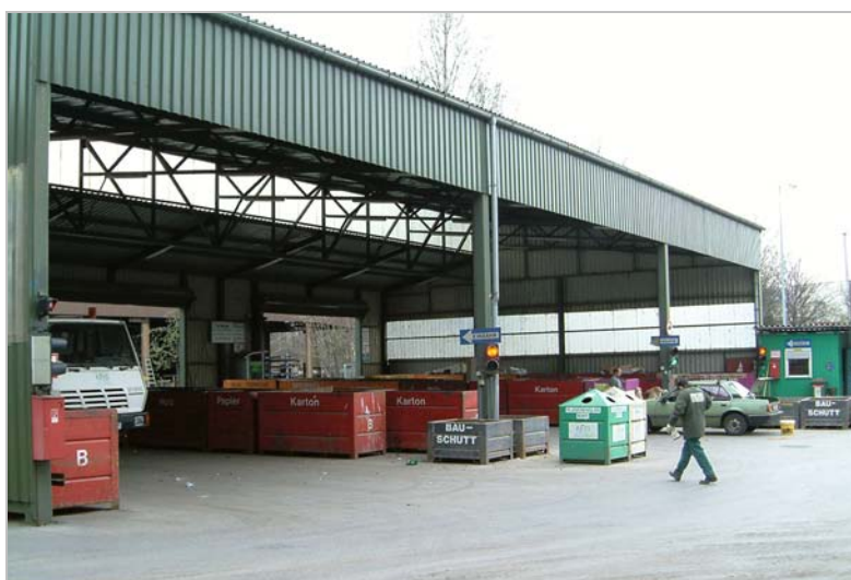
Abb. 56: PAP Graz Sturzgasse – überdachter Übernahmebereich.
