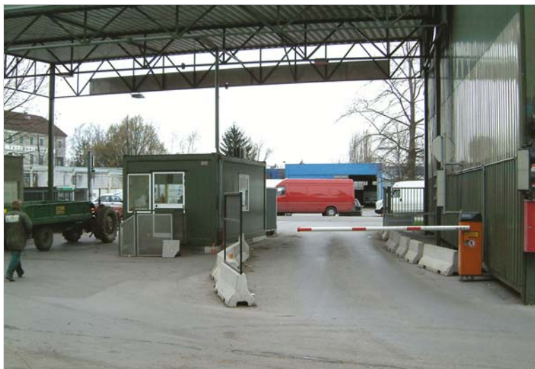
Abb. 59: PAP Graz Sturzgasse – Einfahrtsbereich Innen.
