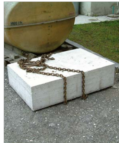
Abb. 50: ASZ Eisbach – angekettete Betonplatte zur Verdichtung.
