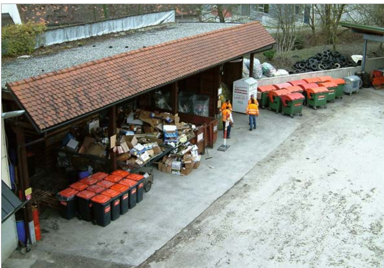
Abb. 45: ASZ Eisbach – offener Lagerbereich.
