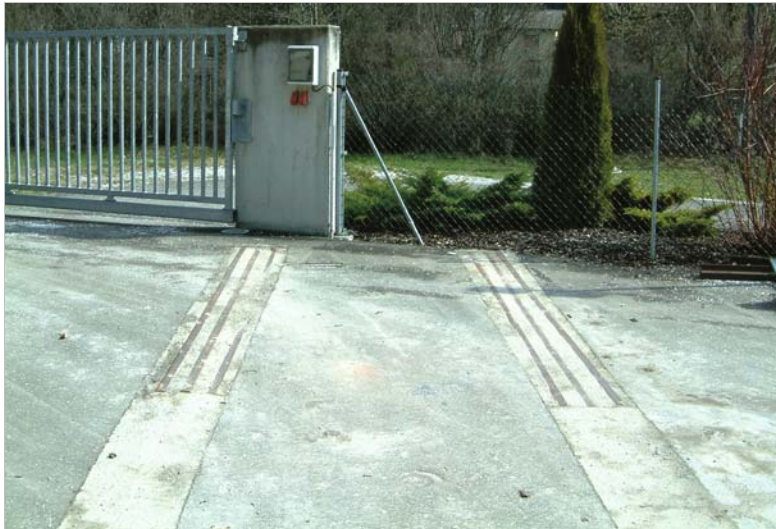
Abb. 68: ASZ Oberes Pölstal - Presscontainer-Stellplatz mit Starkstromsteckdose und einbetonierten Stahlschienen.
