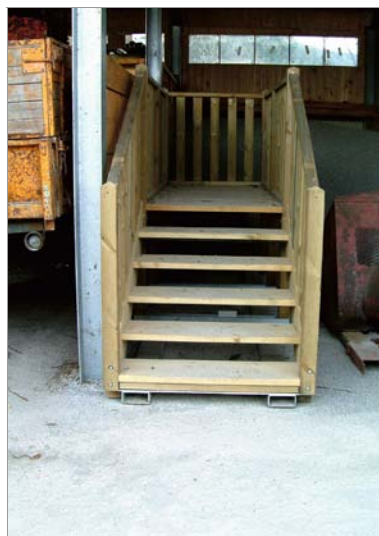
Abb. 49: ASZ Eisbach – mit Hubstapler manipulierbare Holzterrasse.
