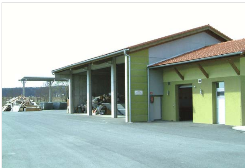
Abb. 70: ASZ Wolfsberg – Abladerampe, Lagerhalle, Problemstoffsammelraum, Büroraum (v. l. n. r.).
