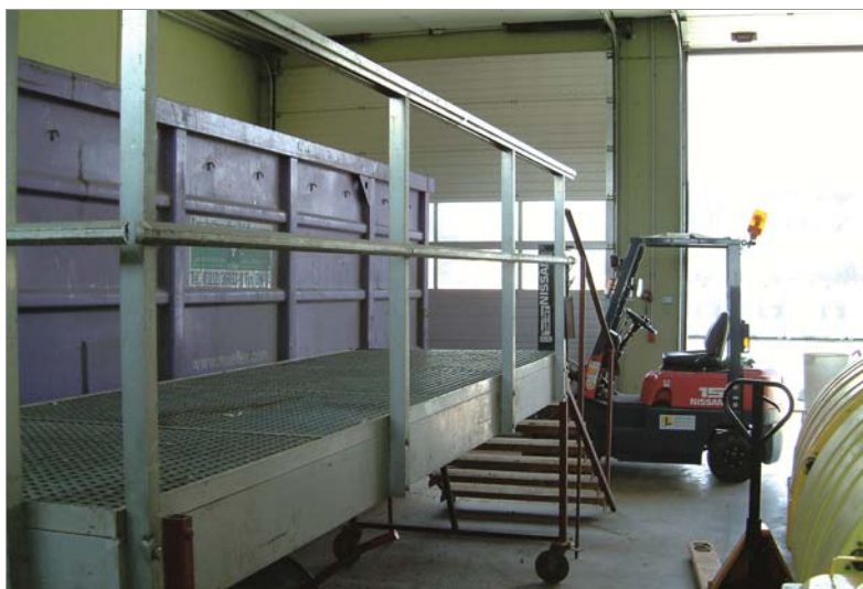
Abb. 42: ASZ Ilz – verschiebbare Treppenrampe.
