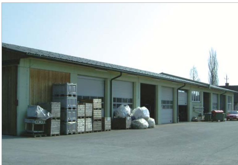
Abb. 40: ASZ Ilz – Lagerhalle.
