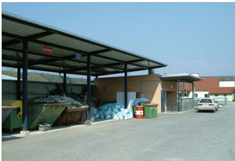
Abb. 36: ASZ Bad Blumau – offener Lagerbereich mit angeschlossenem Problemstoffsammelraum.
