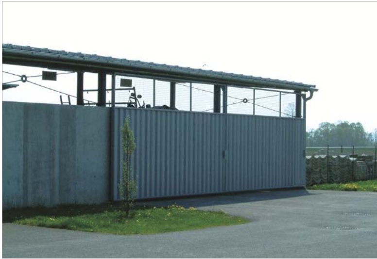
Abb. 38: ASZ Bad Blumau – Abtransportbereich an der ASZ-Aussenseite.
