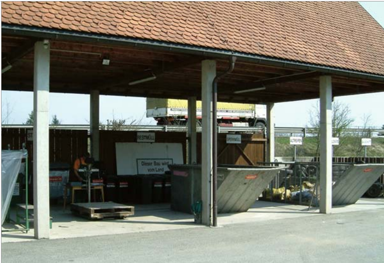
Abb. 27: ASZ Stainz – überdachte Containerstellplätze.
