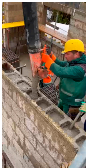
Mantelbetonstein wird mit Beton gefüllt
