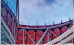
Neue Grätzellen-Fassadenmodule großflächig verbaut
