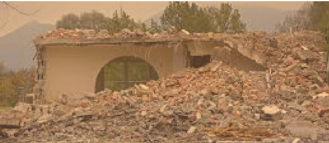
ABBRUCH UND AUSHUB
