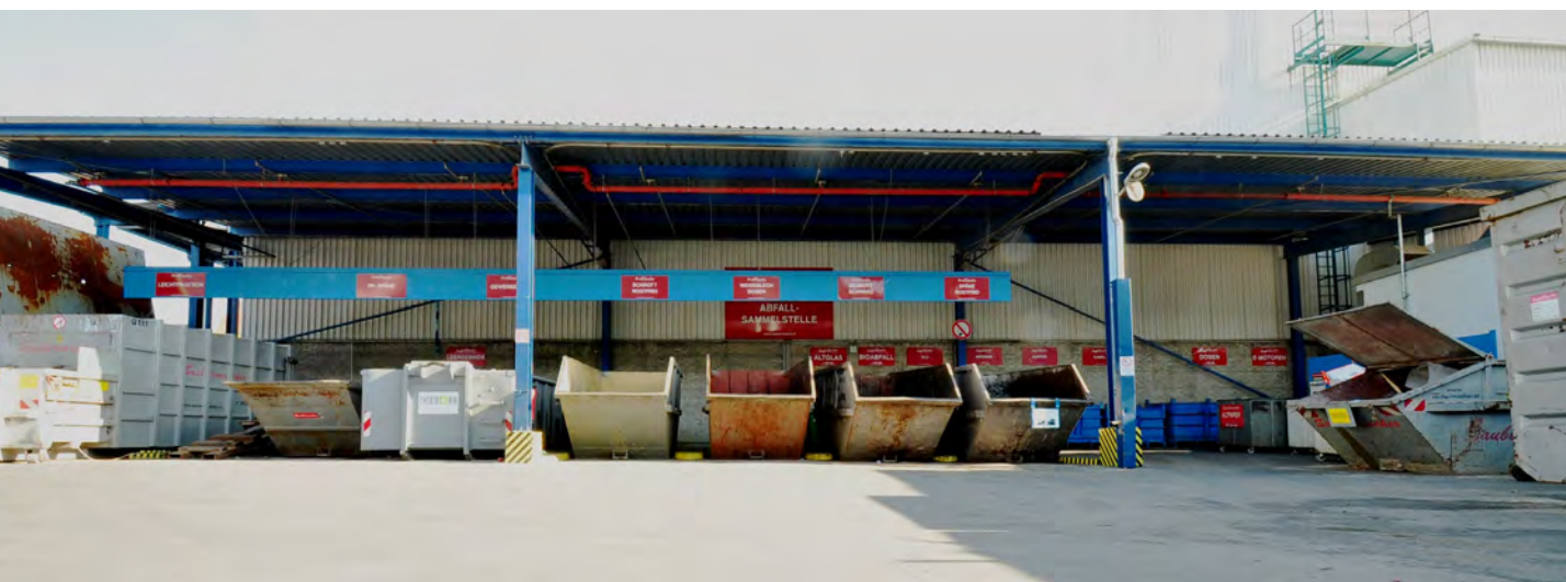
ANDRITZ AG, 8045 Graz, zentrale Abfallsammelstelle für nicht gefährliche Abfälle am Werksgelände
