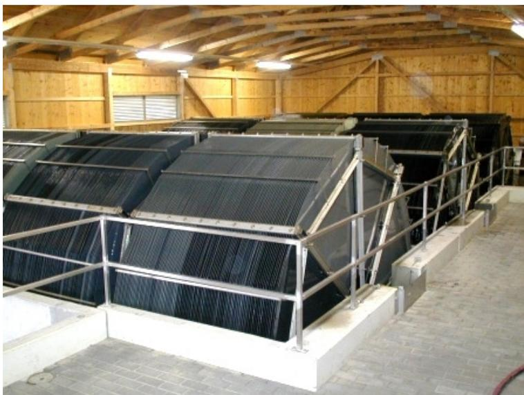
Abbildung 35: Tauchkörperanlage [33]
