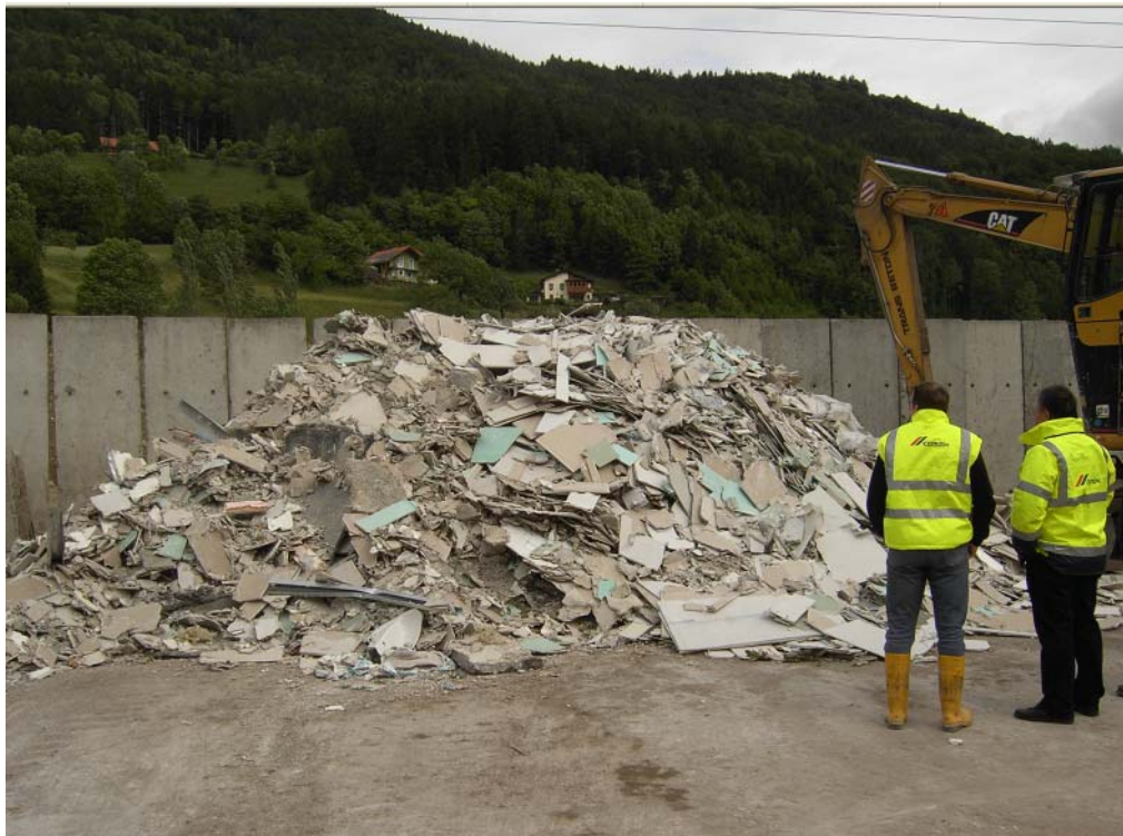
Abb. 1: Gipskartonplattenabfälle Ausgangsmaterial für eine Aufbereitung im technischen Maßstab
