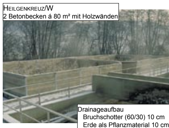
Abb. 16: Aufbau der Schlamm-trockenbecken in Heiligenkreuz
