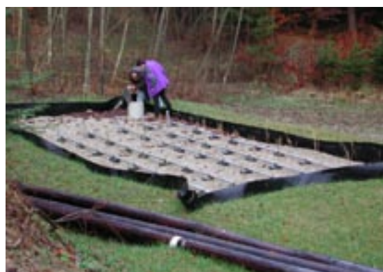
Abb. 34 : Vererdungsanlage Langegg (Klärschlammvererdungsbecken und Pflanzenkläranlage)
