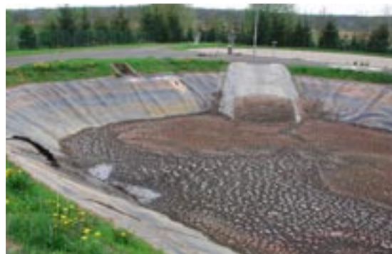
Abb. 32 : Anlage in Wolfsberg i. Schwarzautal, noch unbepflanzt
