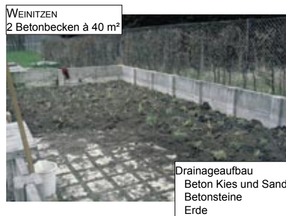
Abb. 17: Aufbau der Schlamm-trockenbecken in Weinitzen
