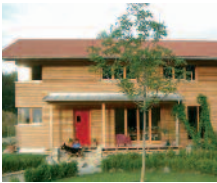
keine Gefährdung des Eigentums der Nachbarn
